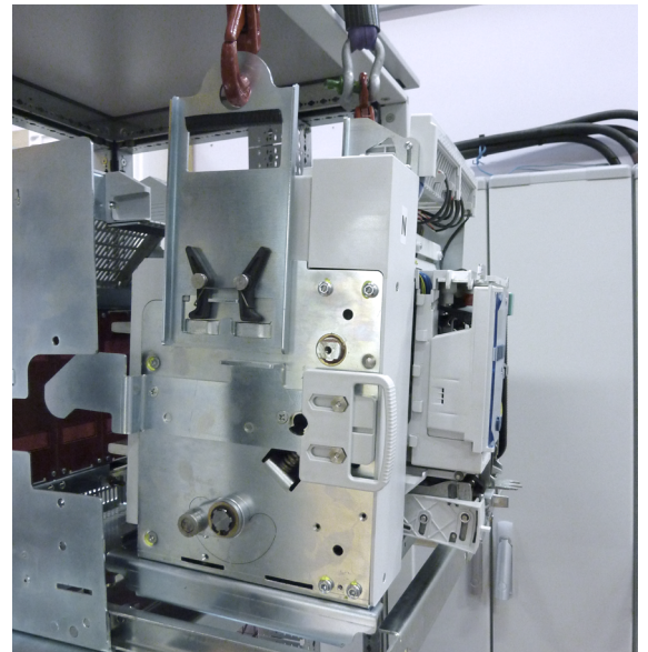
Mise en place d'un DMX 3 débrochable dans sa base
