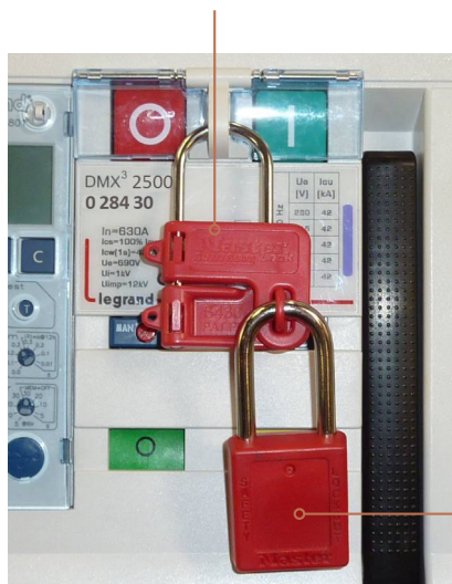
Cadenassage des boutons ON et OFF
