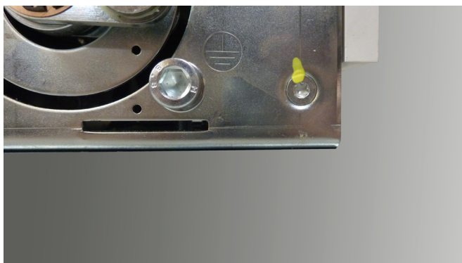
Point de connexion sur base débrochable
