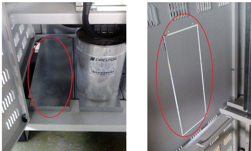
Figura 6: Entrada de cables de los modelos OPTIM FRE.
