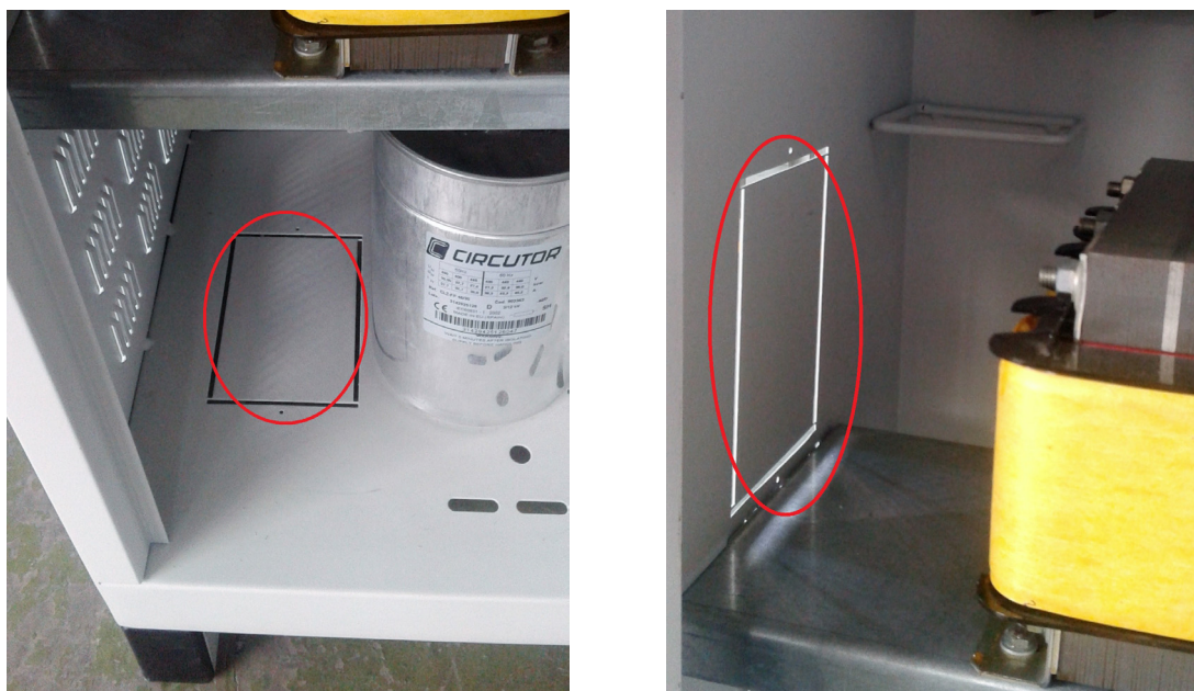
Figura 5: Entrada de cables de los modelos OPTIM FRES.
