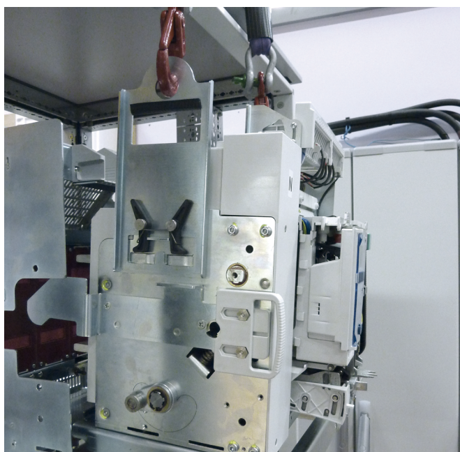
Mise en place d'un DMX-SP débrochable dans sa base.
