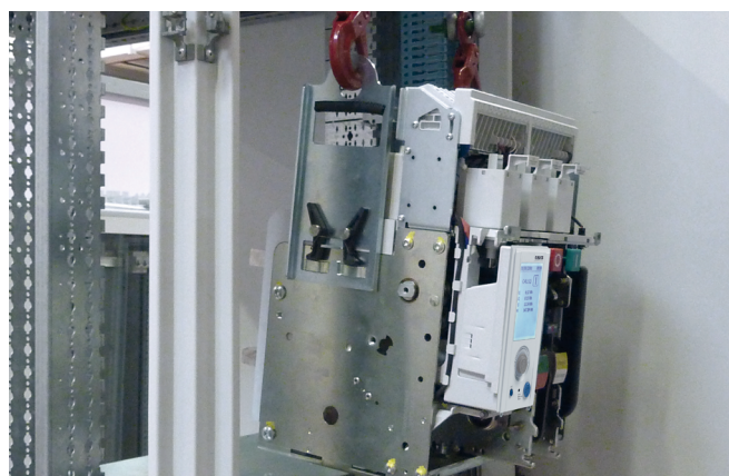
Mise en place d'un DMX-SP fixe
